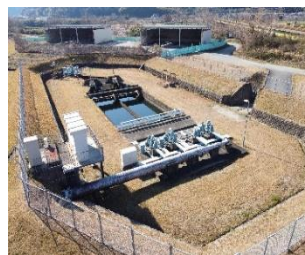
浸水対策予定の施設 （高野取水施設）
