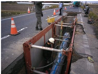
送水管布設替工事の施工例
