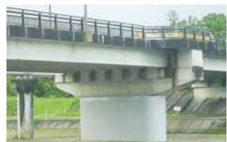
橋脚の補強 一般国道306号 菰野大橋（菰野町）
