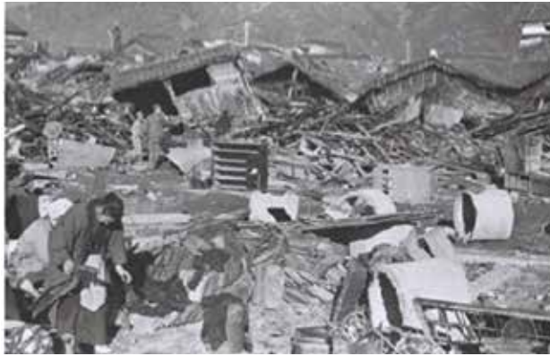
Destrucción producida en la ciudad de Owase (fotografía ofrecida por: Kanenori Ohta)
