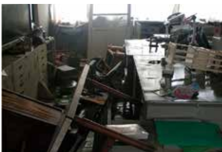
Janela quebrada da sala dos professores
