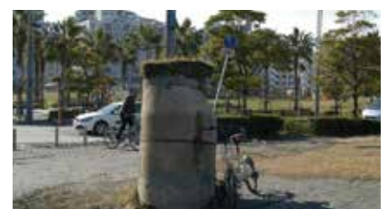
Bueiro expelido do buraco
