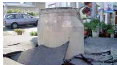
穿出地面的下水管道
