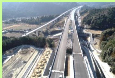
▲ 亀山西JCT (工事当時に撮影)
