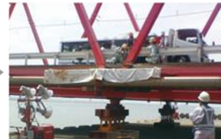
破断が発見された翌日に緊急対策工事に入った
