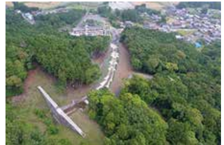
土砂災害防止施設の整備
