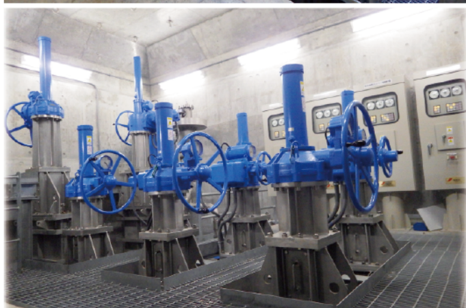
(堤内バルブ室)
