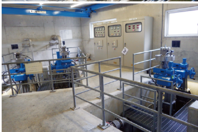
(堤外バルブ室)
