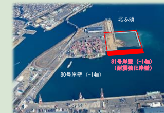
耐震強化岸壁整備箇所
