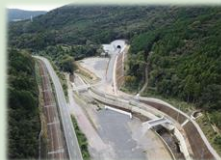
一般国道167号（磯部BP） （令和6年度開通予定）
