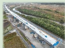
東海環状自動車道 （令和6年度一部開通予定）
