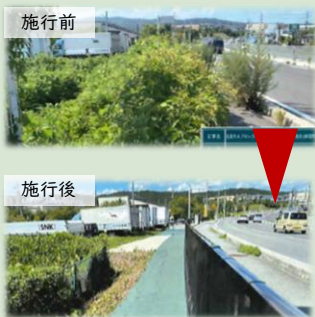
防草シート施工例（名張市）
