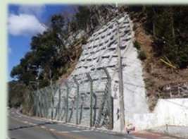
道路の土砂崩れ対策
