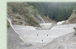
治山ダムの整備 (松阪市)
