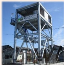
津波避難タワー（志摩市）
