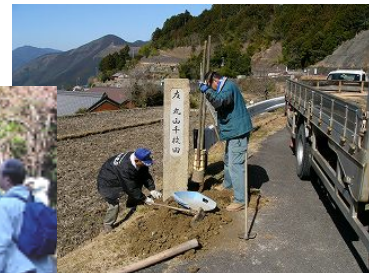
石道標を設置している様子
