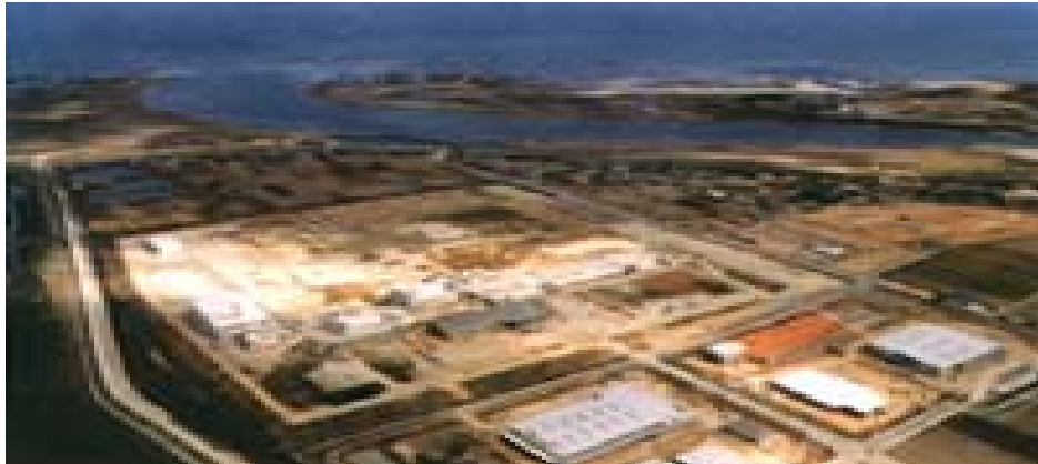
( 図 20 - 1 松阪浄化センター全容 )
