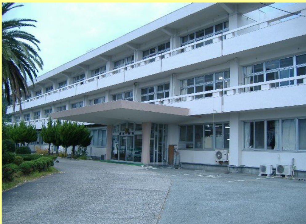
写真 三重県厚生農業協同組合連合会南島病院
