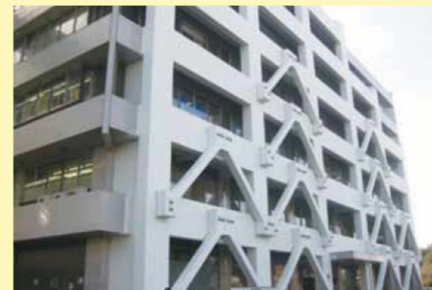
耐震改修の施工例
