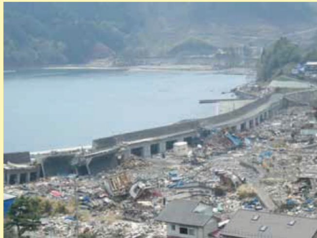
被災した岩手県釜石市内
