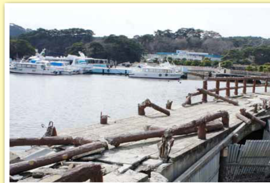
東日本大震災直後の宮城県松島町の状況
