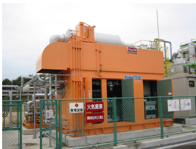
図表3 - 14 発電用ガスエンジンの概観
