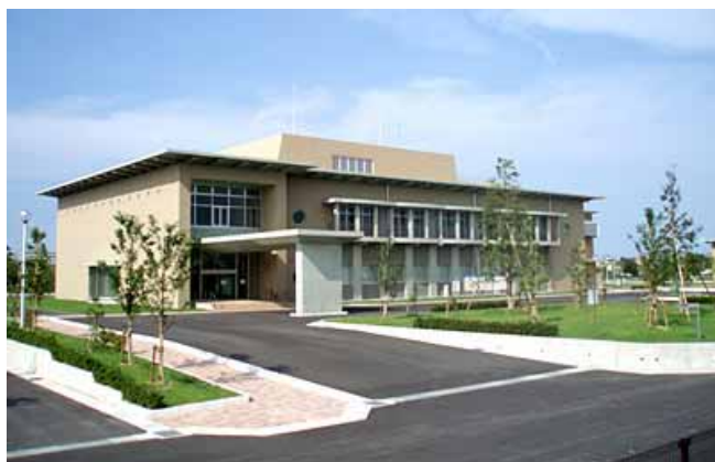
18年6月に供用を開始した宮川浄化センター
