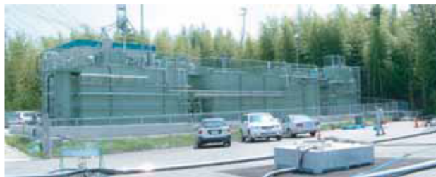
行政代執行による支障等の除去 (有害な産業廃棄物に起因する地下水の浄化施設)
