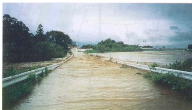
写真：台風14号の洪水で安濃川から三泗川に水が溢れている様子 (H5. 9. 7～9)
