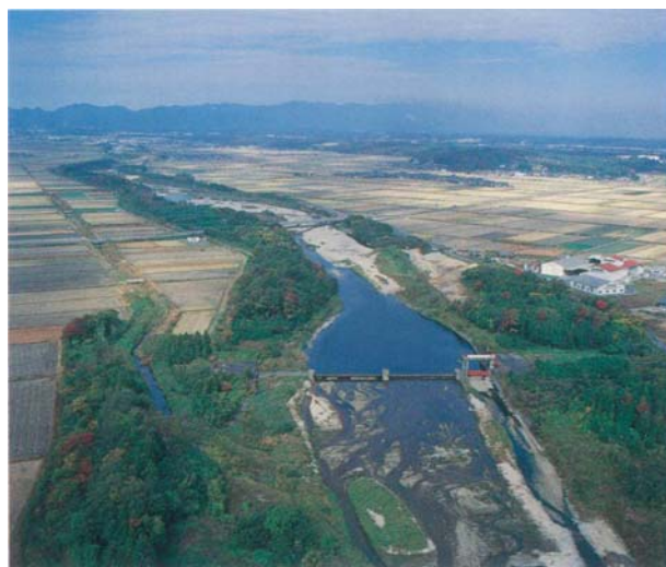
第三頭首工全景
