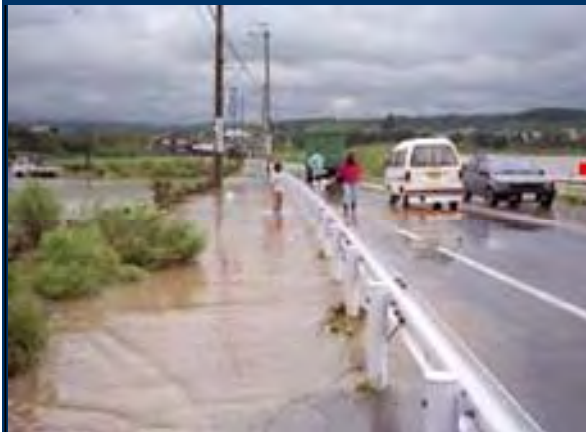
国道422号浸水状況
