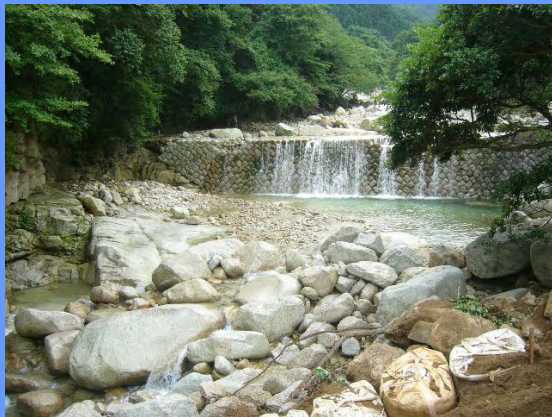
朝明川砂防堰堤(T11-1) (三重県初の練石積堰堤)
