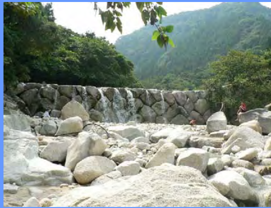
朝明川砂防堰堤(T11-2) (空石積堰堤)
