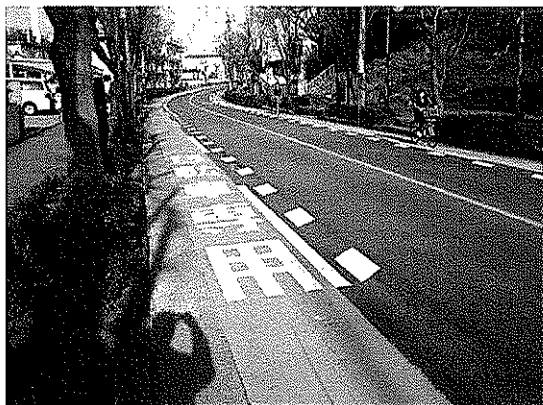
【津駅西（平成20年11月整備）】
