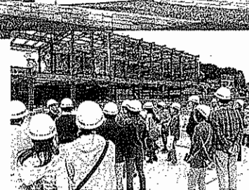
建設現場見学会
