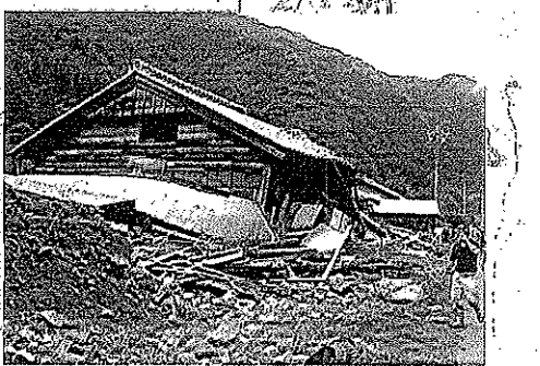
大台町岩井 字持山谷 一級河川の支流で、山腹崩壊が発生。流出土砂が、本流を越えて、対岸の人家が被災。
