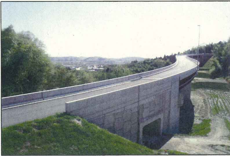
国道 422 号三田坂バイパス (伊賀市三田)
