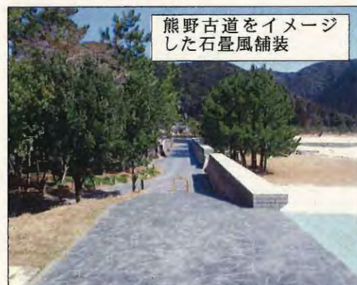
三木里地区（尾鷲市）三木里海岸堤防
