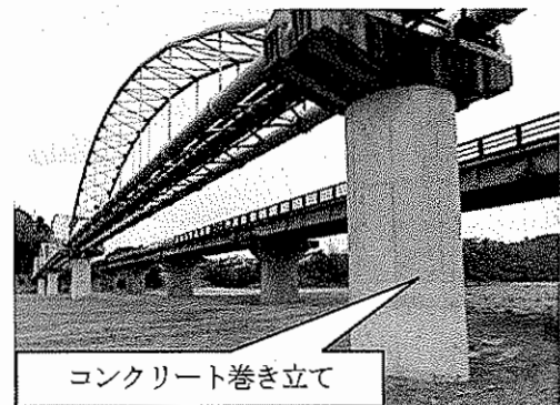
耐震補強工事の実施状況 〔雲出川水管橋下部工〕
