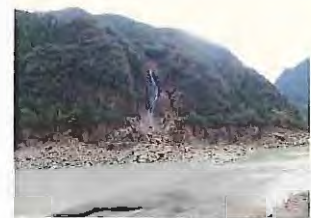
紀伊半島大水害による土砂崩れ
