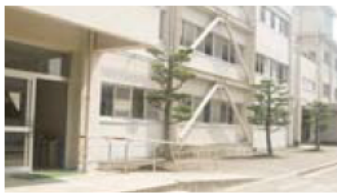
耐震化工事後の状況
