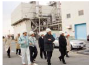
大牟田リサイクル発電所
