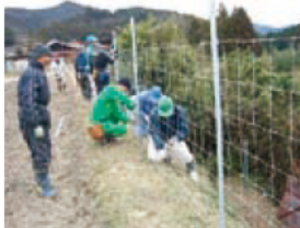
防護柵の設置作業
