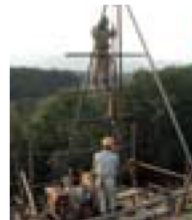
フェロスルト埋め立て施工現場のボーリング調査
