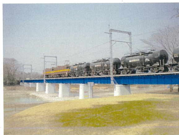
【同橋梁修繕後】
