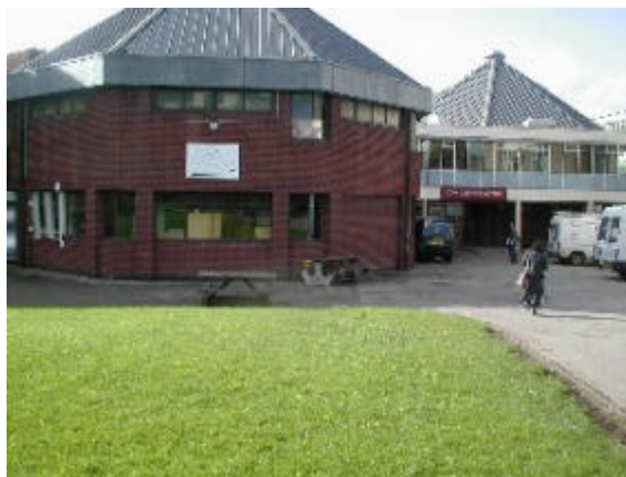
敷地内の建物
