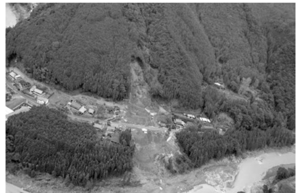
平成 16 年豪雨災害（旧宮川村地内）
