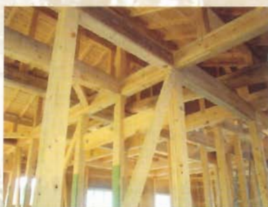
『住宅用建材(施工例)』
