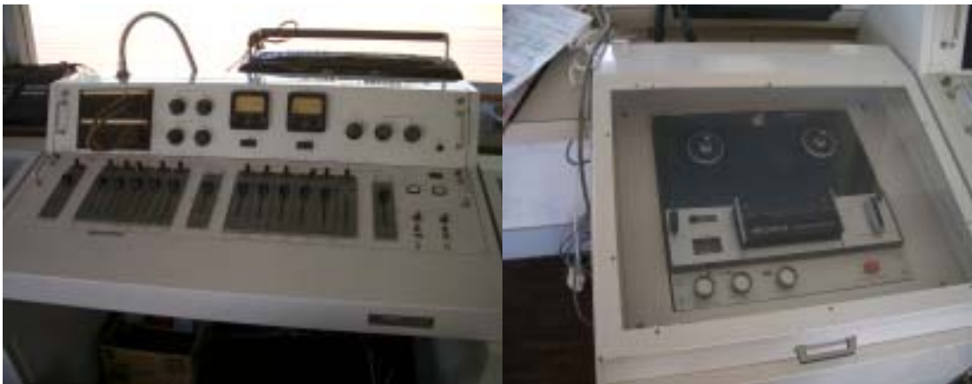
写真 老朽化した放送設備
