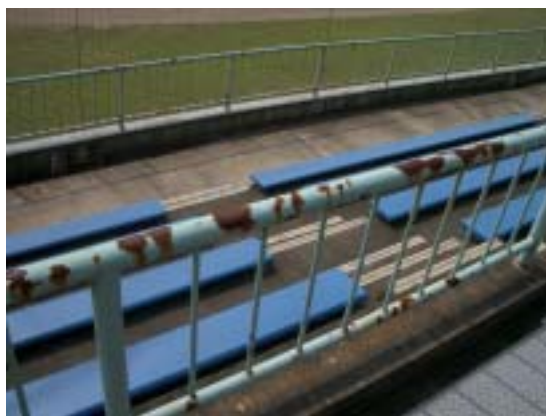
写真 錆が目立つ観客席の手すり
