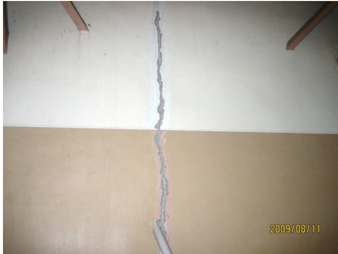
写真 5-26-4 ひび割れが発生している箇所
