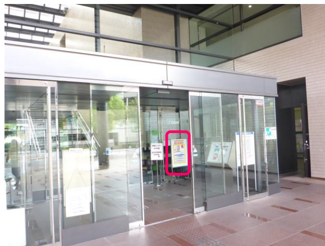
設置場所 津リージョンプラザ 1F 正面玄関
