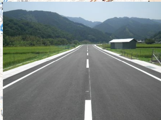
①整備後バイパス
