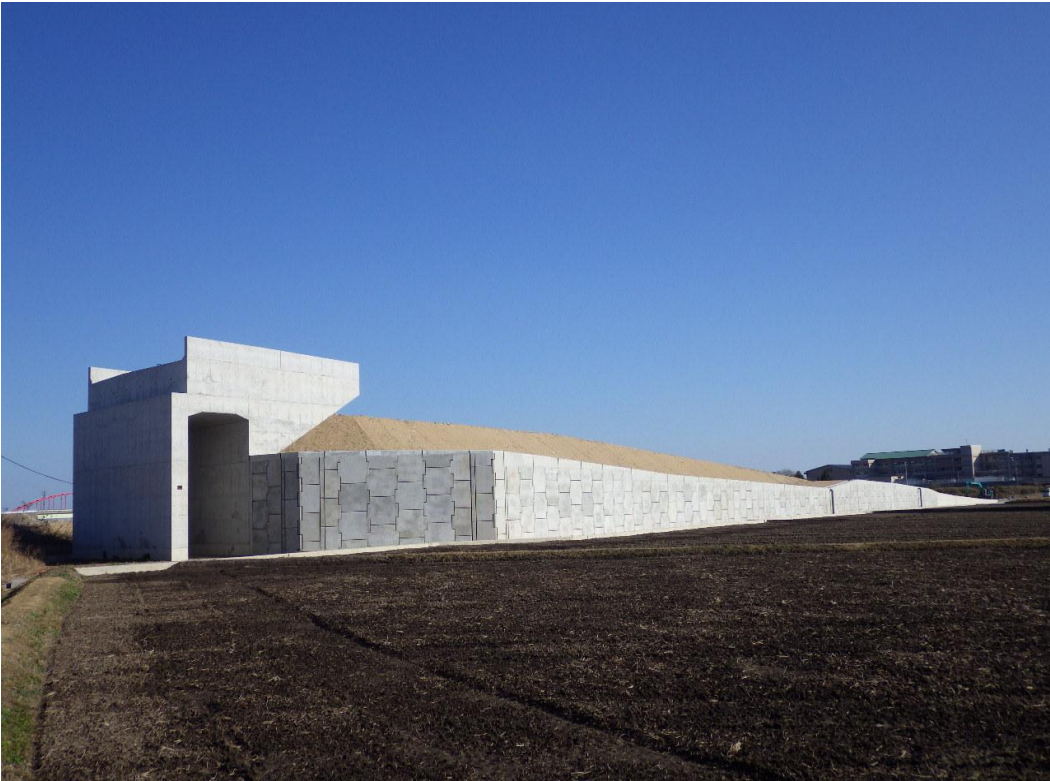
【完成写真：県道三宅一身田停車場線】
