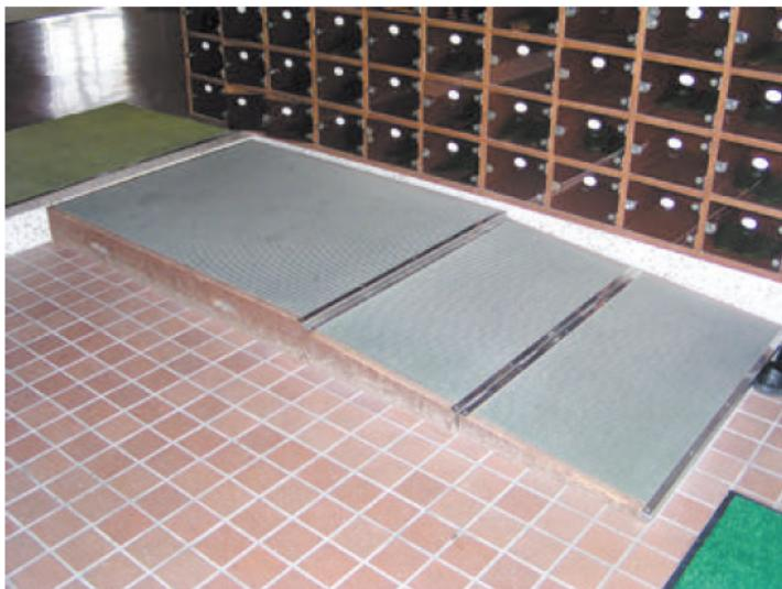
出入口に入った廊下に段差があるのですが、周囲の廊下等の色彩と識別しやすい色彩で移動式の木製傾斜路を設けて、車椅子使用者等が移動できるようにしています。なお、この傾斜路は折りたたみ式となっています。そのためか、若干の段差が発生しているのが残念です。
