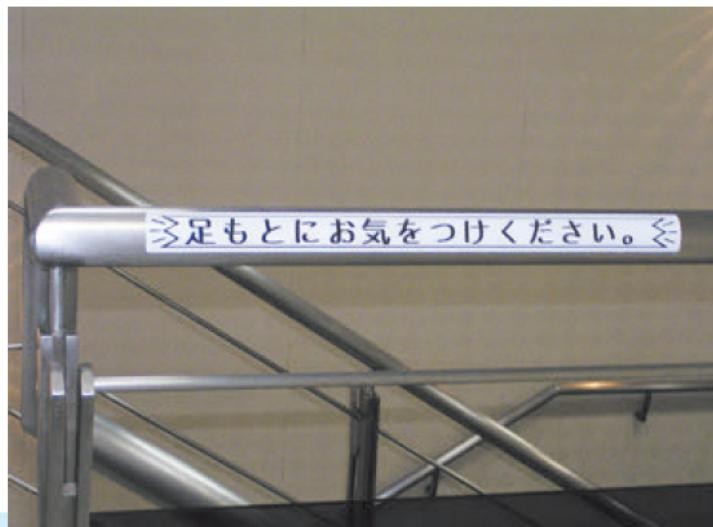
階段付近の廊下の手すりに、印字テープで足元の危険を周知する表示を設けています。
