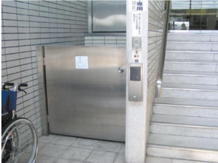
廊下に段差が発生していましたが、機械式段差解消装置を設けることで車椅子使用者が移動できるようにしています。
