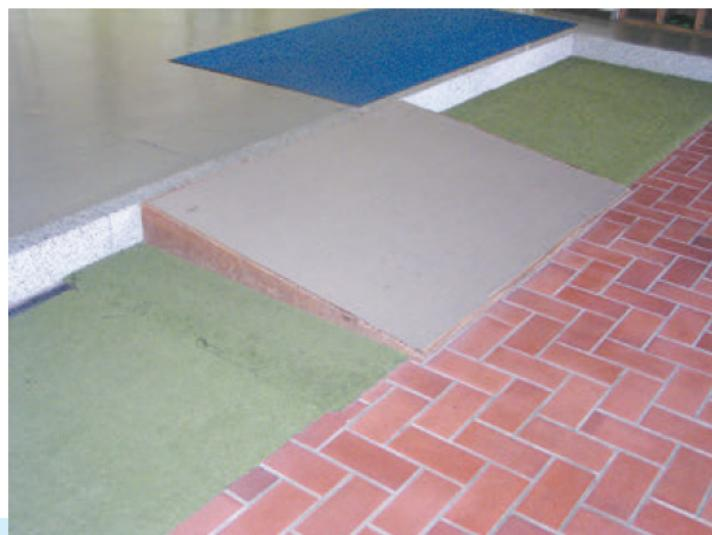
出入口に入った廊下に段差があるので、周囲の廊下等の色彩と識別しやすい色彩で移動式の木製傾斜路を設けて、車椅子使用者等が移動できるようにしています。
