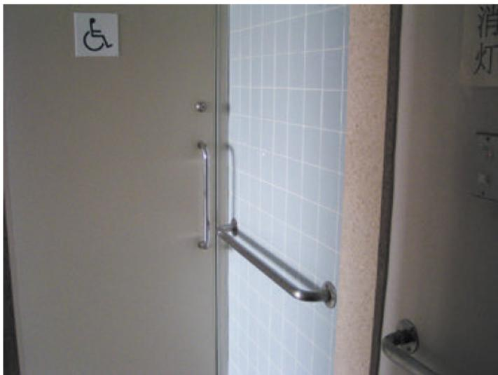
多数の介護が必要な方が利用される施設です。廊下に手すりを設けていますが、車椅子使用者用便所までの室にも手すりを連続して設けています。
