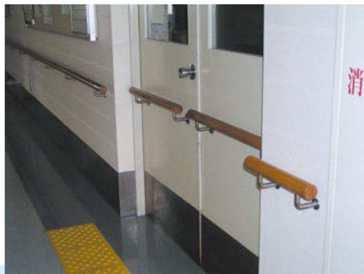
多数の介護が必要な方が利用される施設です。廊下に手すりを設けていますが、ドアにも手すりを設けることで手すりを連続させています。
