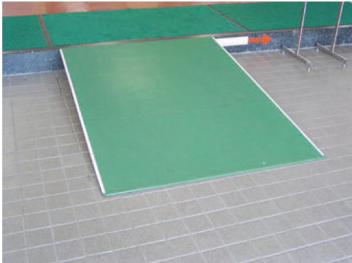
出入口に入った廊下に段差があるので、周囲の廊下等の色彩と識別しやすい色彩で移動式の傾斜路を設けて、車椅子使用者等が移動できるようにしています。なお、傾斜路はアルミ製で軽量化されています。
