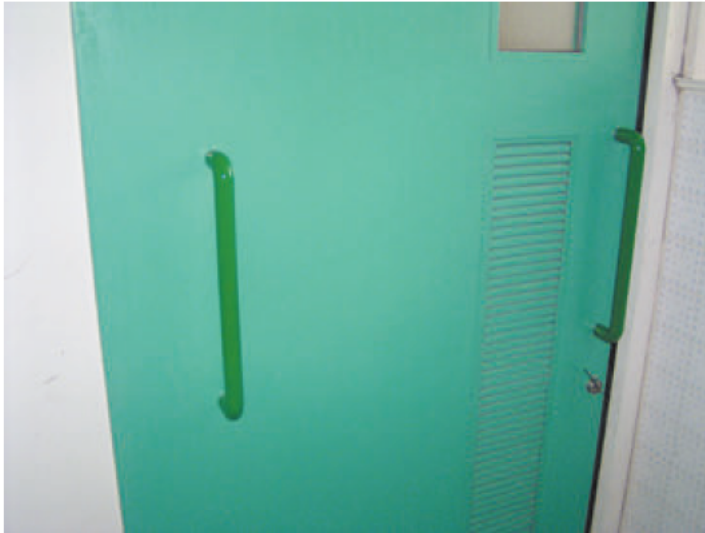
多機能便房の出入口の戸です。両側に棒状手すりを設けています。
