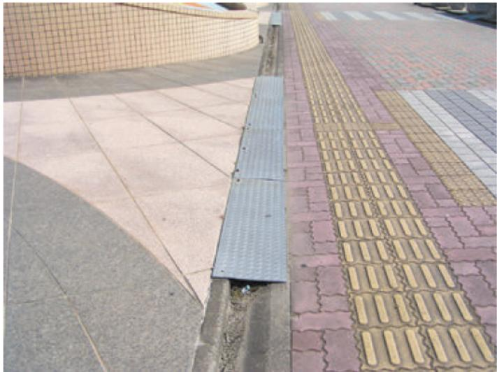
建物エントランス付近にL型側溝による段差が生じていましたが、ステンレス鋼板をボルト固定することで段差解消しています。
