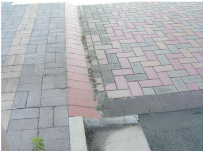
建物のエントランス周辺ですが、段差解消のため境界ブロックを傾斜タイプのものとしています。また、境界ブロックと路面の色彩との明度差を大きいものとしています。
