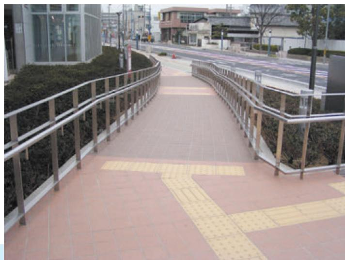
曲線の傾斜路ですが、傾斜路センターにて規定の勾配を確保しています。なお、傾斜路には横断勾配を設けていません。
