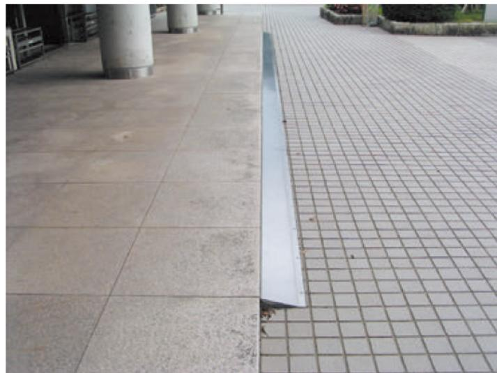
建物エントランス付近に段差が生じていましたが、ステンレス鋼板をボルト固定することで段差解消しています。
