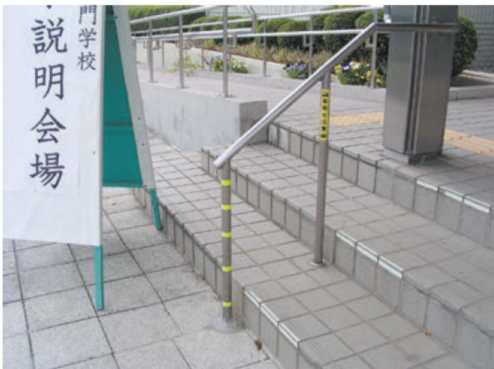
階段の段鼻と路面の色彩の明度差を大きいものとするため、段鼻に着色を行っています。また、手すりを識別しやすいように、蛍光テープ、印字テープを利用した文字による注意喚起を行っています。
