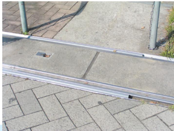
敷地内の通路への出入口に門扉のレールによる段差が発生しているのですが、塩化ビニル管を利用して段差の解消を行っています。
