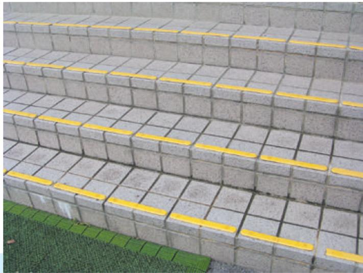
階段の段鼻と路面の色彩の明度差を大きいものとするため、黄色のプレートを後付けした事例です。
