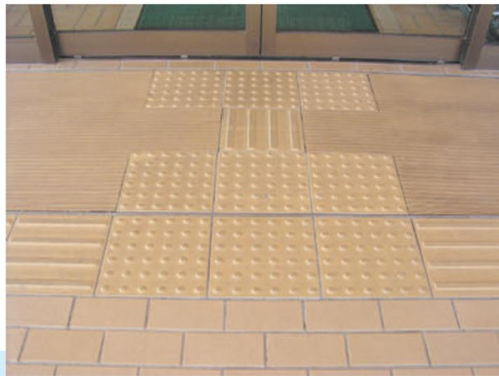
視覚障害者誘導用ブロックと路面の色彩の明度差がないのは良くないのですが、玄関マットを路面に埋め込み設置するようにすることで、玄関マットが視覚障害者誘導用ブロックを隠さないよう固定できます。
