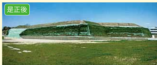
原因者が措置を講じる見込みがなかったことから、行政代執行(覆土によって空気を遮断し燻焼状態を解消する措置)を実施
