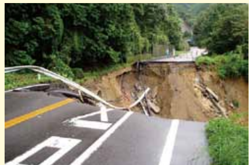
台風により路面陥没した国道42号
