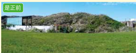
不適正な処分が原因で、3度に亘って火災・悪臭が発生したため、原因者に対して措置命令(火災発生防止の散水や可燃物撤去等)を发出
