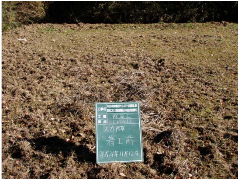
写真 4-3-14 整備状況(除草工(人力)：除草前・ハナショウブ植栽地：平成24年11月12日)
