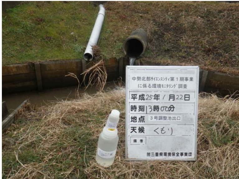
写真 4-1-35 濁水調査状況(通常降雨時)(3号調整池出口)(平成 25 年 1 月 22 日)
