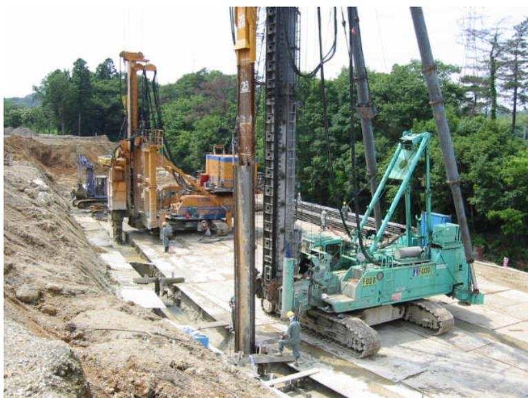
図 I — 9 地中連続壁設置工事の様子
