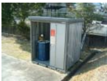
貯蔵施設（三重県庁）
